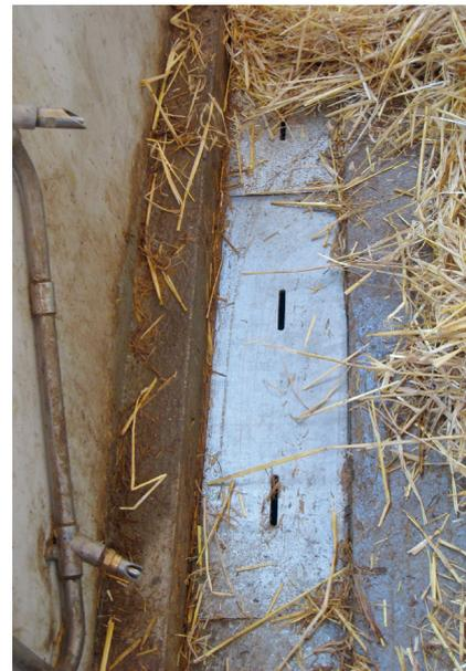
Ein Jauchekanal mit geschlitzter Abdeckplatte schafft eine trockene Fläche.
