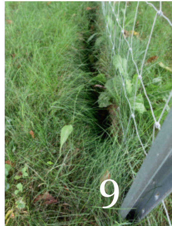
Der Zaun wird in die Furche gestellt, damit ist auch ein Untergrabungsschutz hergestellt.
