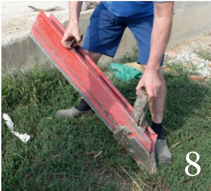
Aufsatz für Baggerschaufel zum Ausheben eines schmalen Grabens, in den der Zaun gestellt wird.
